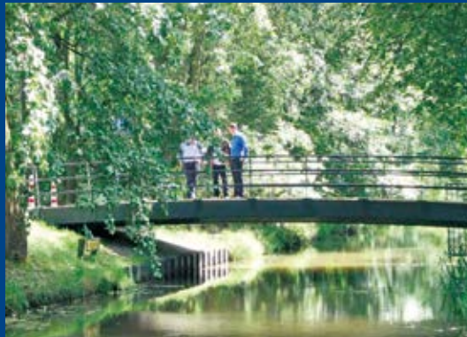
サンドイッチ床版を使用した橋です 優美な曲線が橋をスタイリッシュに仕上げます
