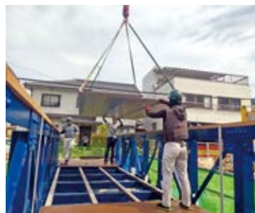
クレーンで床版設置
