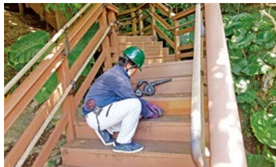
▲部材交換作業
