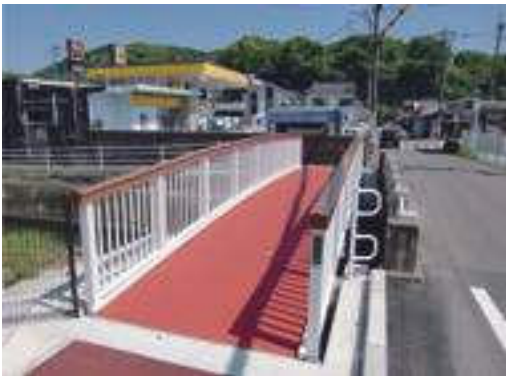
水俣旧釣船鉄工所跡地 側道橋（熊本県）
