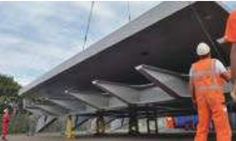
Leegh Water Bridge（15mW×15mL）車道橋用床板は VI 法で製作
