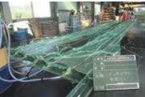
VI 床板 製作状況
