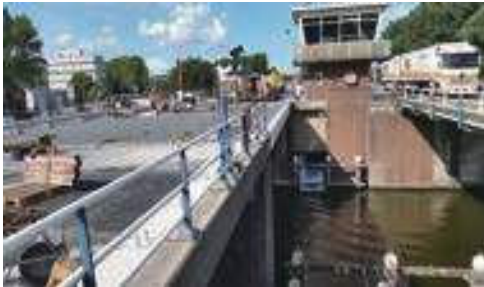
Leegh Water Bridge（15mW×15mL）車道橋用床板は VI 法で製作
