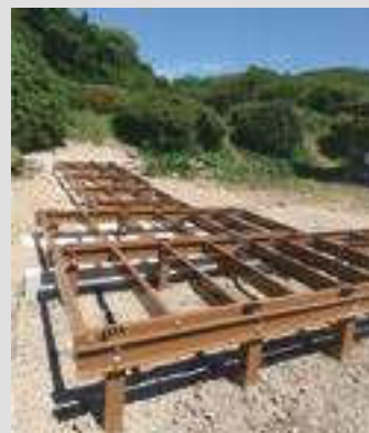
〈床板を設置する前の構造〉
