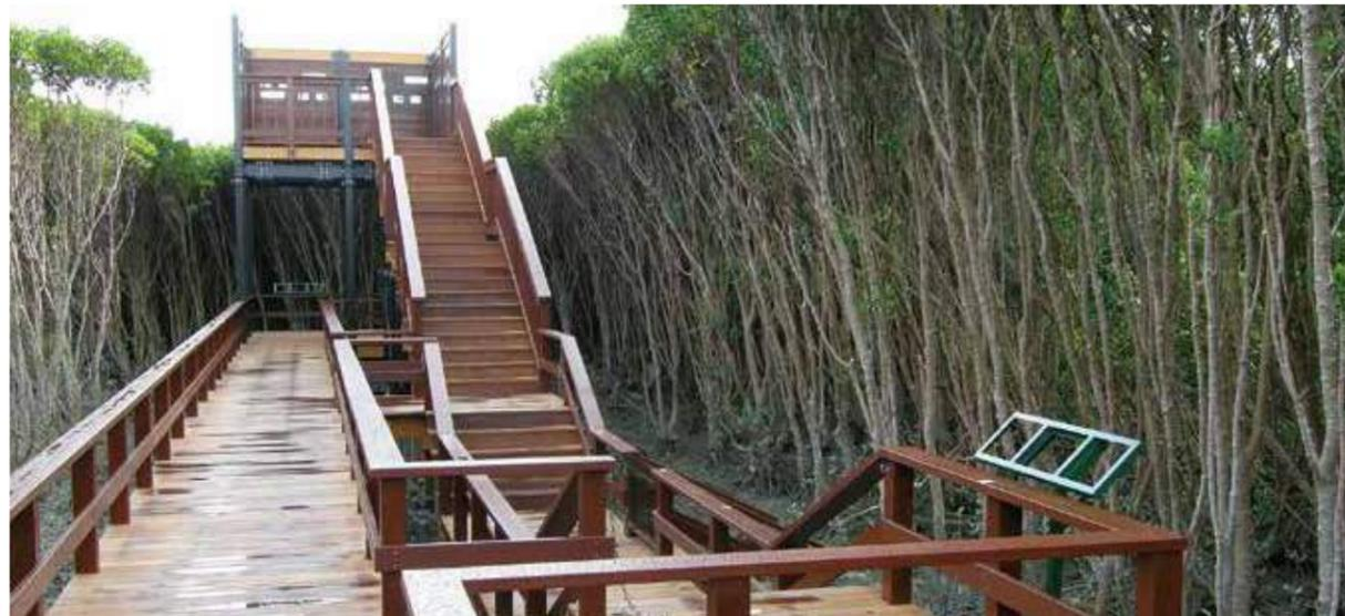
地盤の軟弱な湿地帯や湖沼地においては、従来のコンクリート基礎では対応できないことがありますが、ピン foundation 工法の場合は、ピンの根入れの長さを非常に深くすることができるのでこのような軟弱な地盤にも対応することが可能です。また、コンクリート打設の必要がないので地表面に水がある場合でも簡単に施工することができます。
