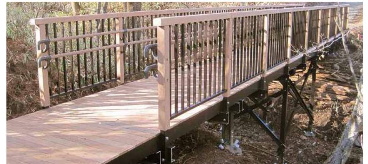
通常のコンクリート基礎の場合は、施工現場への進入路をつくるため、木を伐採したり、地面を削るなどして自然破壊が大きくなりますが、ピン ファウンデーション工法では資材の運搬から基礎設置まですべて人力で可能なので自然破壊を最小限にすることができます。
