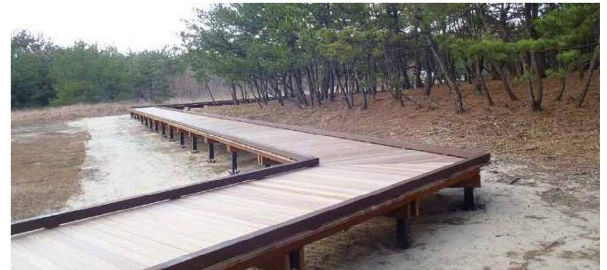
通常のコンクリート基礎を設置する場合、地盤面の掘削が必要となりますが砂地の場合は掘削しても砂が流れ落ちてくるためコンクリート基礎の大きさに比べかなり広範囲に掘削する必要が生じてきます。ピン ファウンデーション工法の場合は、定着ブロックを介してピンを打込むだけなので砂地でも非常に簡単に設置できます。
