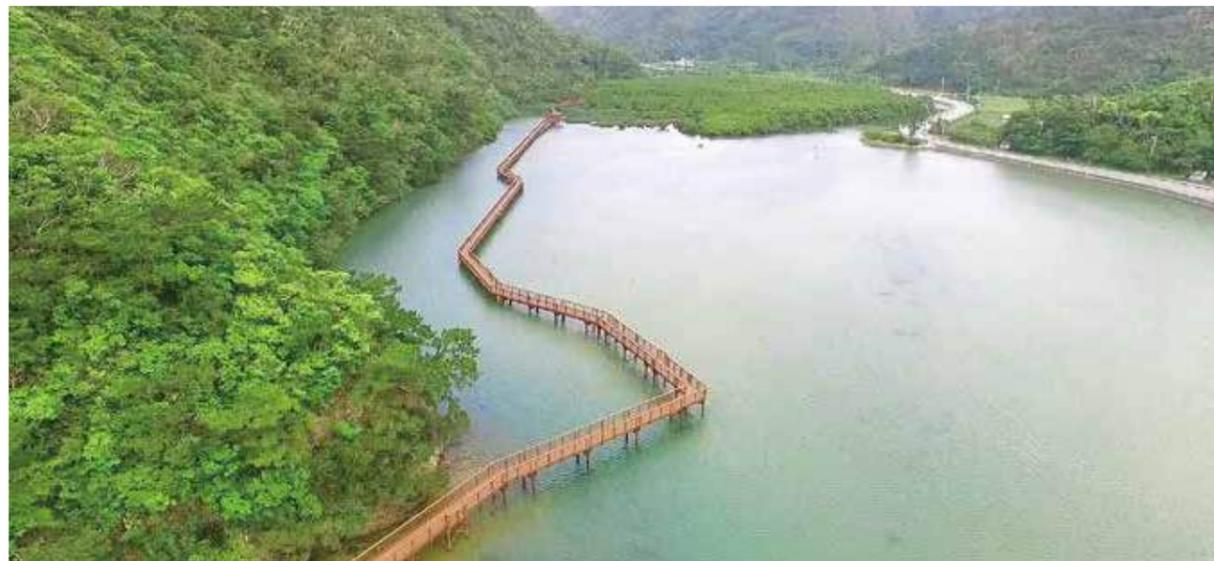
軟弱地盤のため、基礎工事が大掛かりになる現場や池、運河で水を抜くのに大きな費用のかかる現場、あるいは資材を搬入するのに非常に手間のかかる現場等には軽量でしかも人力で施工できるピン ファウンデーション工法が最適です。ケースによって異なりますが、基礎工事のコストを大幅に削減することも可能です。
